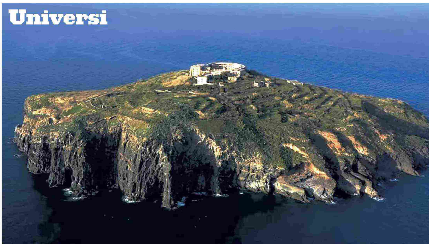
Il carcere dell'isola di Santo Stefano, nell'arcipelago delle Isole Ponziane, costruito nel 1795 e ora in disuso
